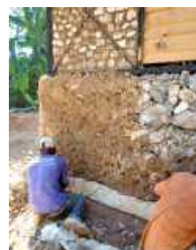
enduisage du mur MPC
