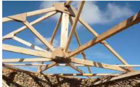
8. poser une toiture
