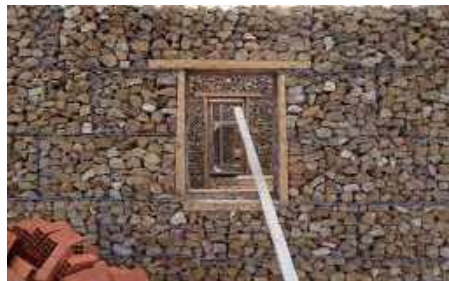
6. insérer des menuiseries
