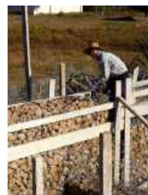
montage des murs avec gabarits
