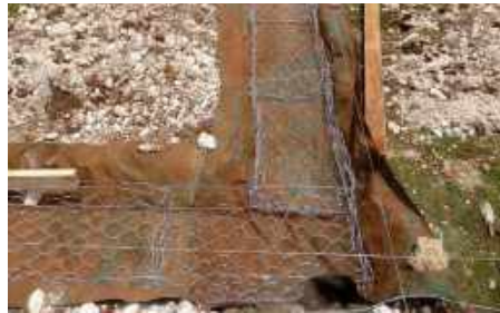
4. assembler les cages en rangées
