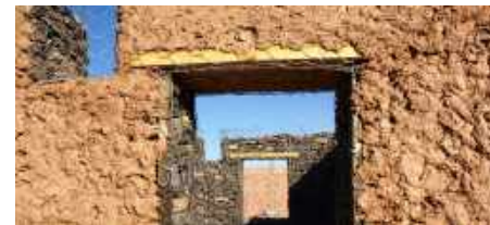
enduit de terre et chaux
