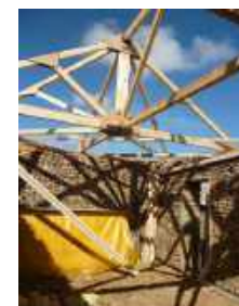
toiture autoportante à 4 pans
