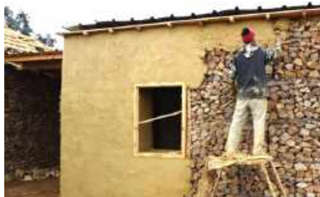
7. enduire les murs
