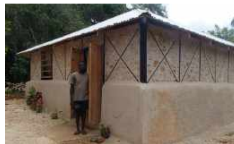
la maison de 35m 2 est livrée en 6 semaines
