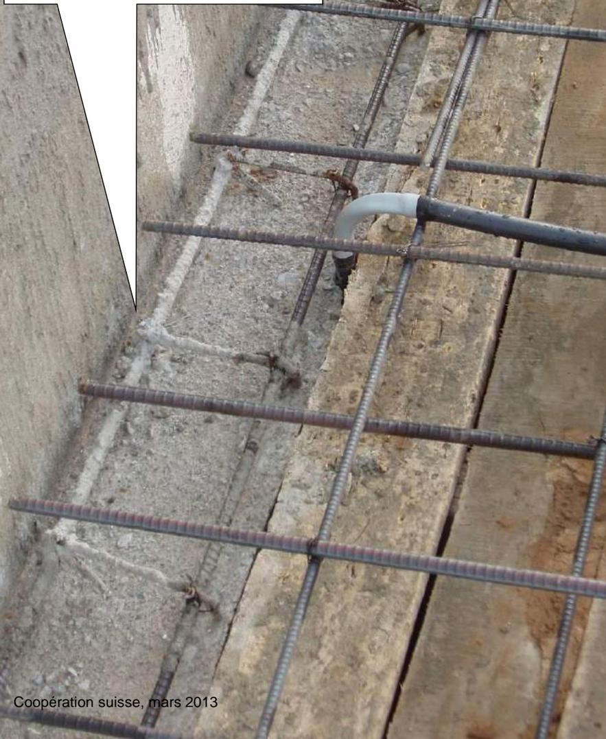
Chaînage trop bas; armatures sans crochets; absence d'écarteurs.
