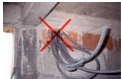
**Fig. 66 - Gaines placées dans les chaînages : à proscrire**
