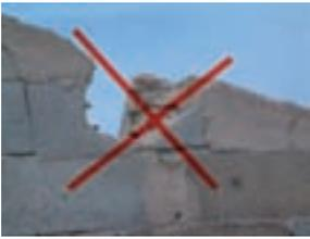
**Fig. 64 - Chaînage coupé pour la pose de pannes de toiture : cette disposition est proscrite. En bas vue de détail**
