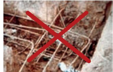
Fig. 74 - Absence de béton de propreté : à proscrire
