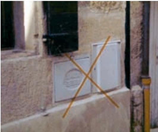
De même, les murs de contreventement ne doivent pas comporter de coffrets encastrés (fig. 41). Ces derniers peuvent être intégrés dans les murs de la structure secondaire (qui ne participe pas au contreventement).
