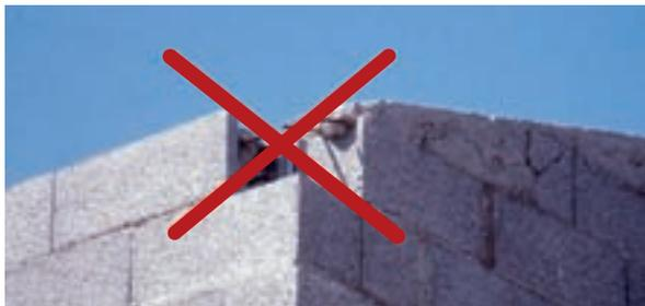
**Fig. 61 - Absence de continuité du chaînage en angle. La fonction « chaînage » n'est pas assurée: cette disposition est inacceptable**
