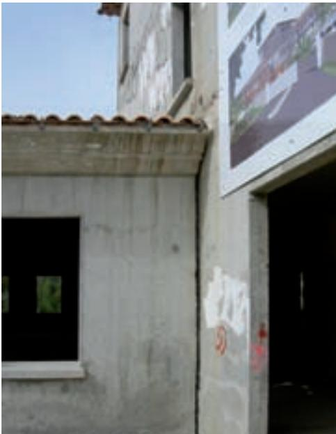
Fig. 28 - Joint sismique (vide de tout matériau) dans le cas d'un retrait d'étage important
