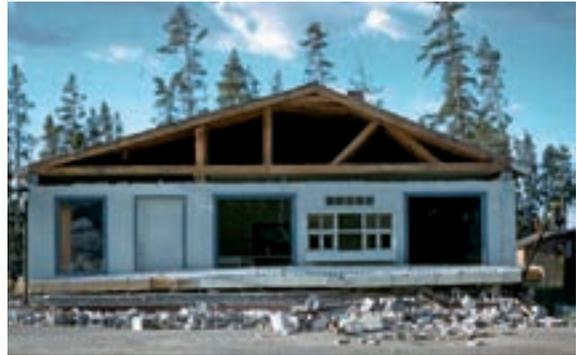
**Fig. 95 - Effondrement d'un mur pignon en maçonnerie non solidaire de la charpente**
