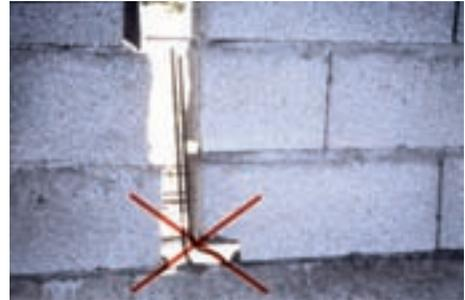
Fig. 52 - A éviter: armatures de chaînage vertical déviées
