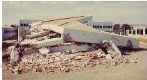
Fig. 17 - Effondrement de constructions exposées à une torsion
