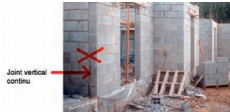
**Fig. 38 - À éviter : joint vertical continu. En cas de séisme, le joint peut s'ouvrir et donner ainsi lieu à un entrechoquement des maçonneries situées de part et d'autre**
