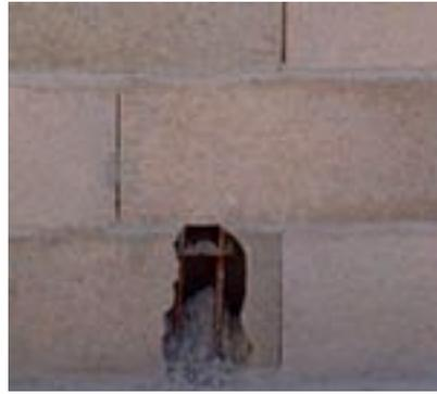
**Fig. 67 - Trous de visite permettant de vérifier le remplissage des chaînages verticaux. L'image montre un remplissage incorrect**
