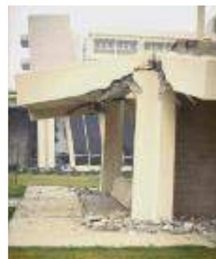
**Fig. 15 - Rupture de porte-à-faux sous l'effet d'oscillations verticales**
