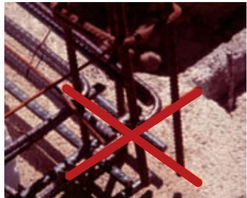
Fig. 60 - A éviter: la disposition des armatures longitudinales est correcte mais le chaînage vertical est excentré. En outre, les armatures de recouvrement du chaînage vertical (attentes) sont absentes
