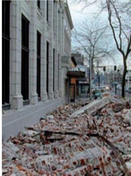
**Fig. 106 - Chute d'acrotères en maçonnerie non chaînée**
