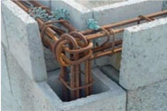
**Fig. 55 - Continuité du chaînage haut du dernier niveau obtenue par des boucles placées dans trois directions.**
