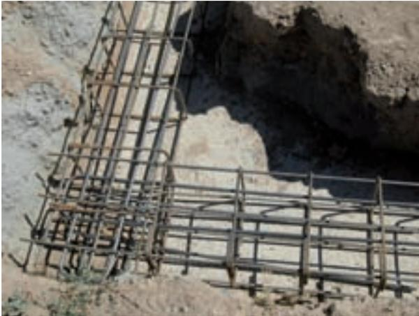
Fig. 73 - Semelle filante armée comme un chaînage. La continuité mécanique dans les angles est assurée par des boucles en forme de U
