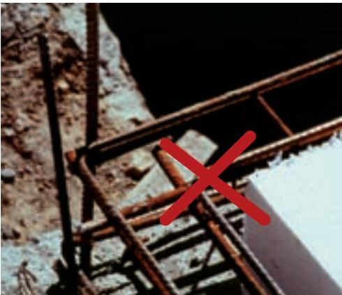
Fig. 59 - A éviter: disposition des armatures longitudinales donnant lieu à une poussée au vide. En outre, les armatures du chaînage vertical se trouvent à l'extérieur de celles du chaînage horizontal, ce qui est inacceptable
