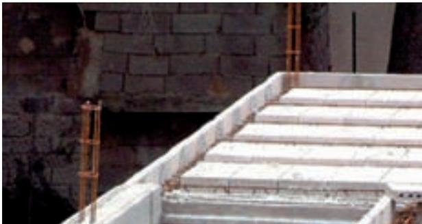
**Fig. 51 - Armatures des chaînages verticaux en attente de recouvrement, longueur 60 Ø**
