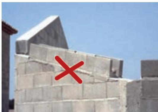
**Fig. 62 - Assise inclinée du chaînage de couronnement: disposition déconseillée en zone sismique**
