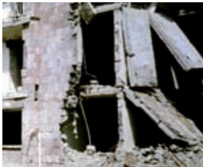
**Fig. 80 - Arrachement de planchers lors d'oscillations sismiques**
