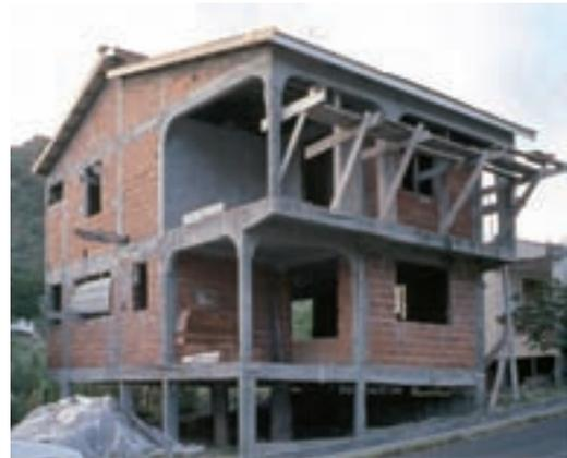
**Fig. 37 - Exemple de maison sans murs en vide sanitaire. Cette configuration nécessite une vérification de sécurité selon l'Eurocode 8**
